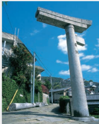
原爆の爆風によって半分が倒壊した一本柱鳥居
