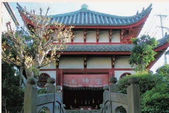
旧唐人屋敷内土神堂・観音堂・天后堂
